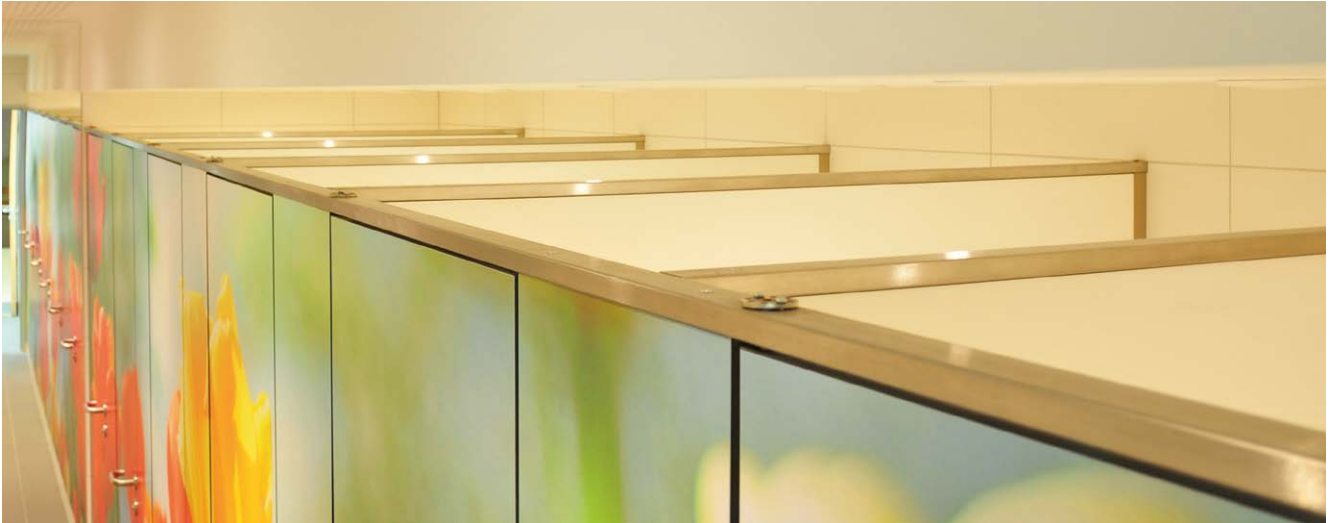
/// Detailansicht Kopfleiste Vorderwand und Mitteltrennwände
